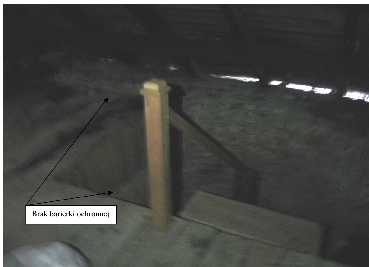
Zdjęcie 14 – brak barierki ochronnej przy wyjściu na strych z klatki schodowej
