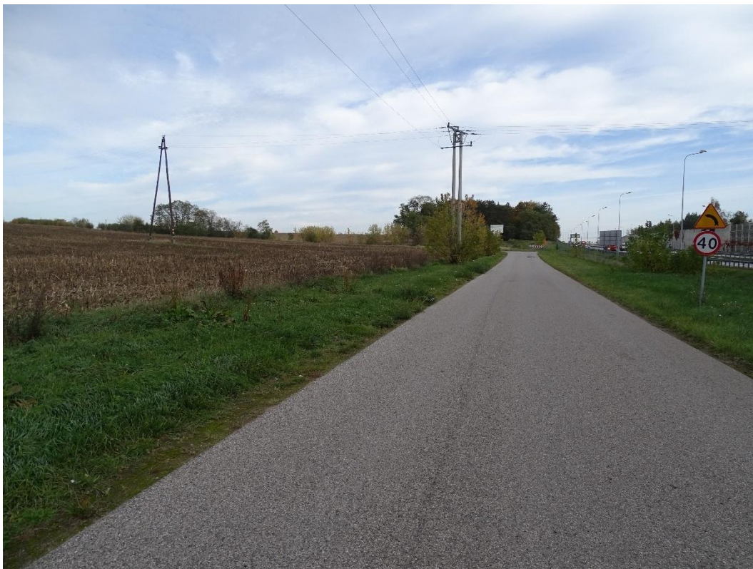
4. Wgląd na drogę serwisową z odcinkiem bez ekranu akustycznego przy drodze S8.
