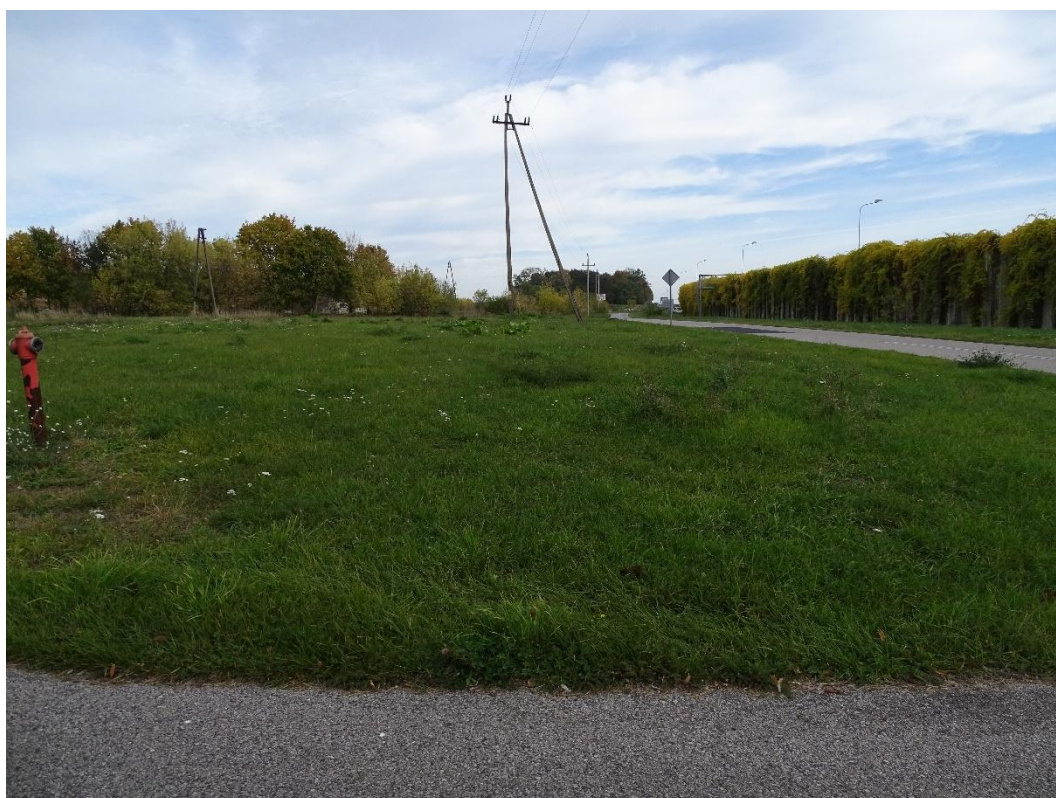
1. Wgląd na drogę serwisową i ekran akustyczny przy drodze S8.
