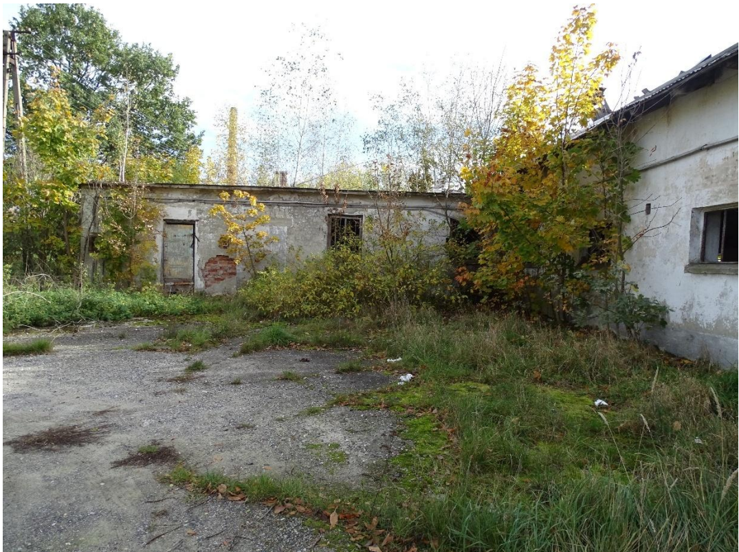
11. Dawna zabudowa gospodarcza na działce ewidencyjnej Nr 886/4.
