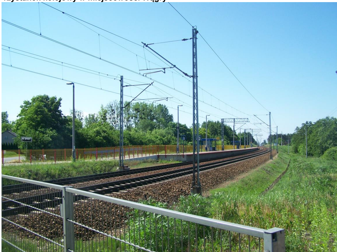
Fot. 10 Przystanek kolejowy w miejscowości Wąгры
