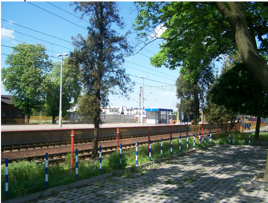
Fot. 9 Linia kolejowa
