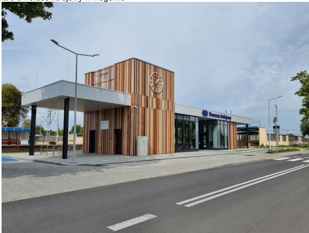
Fotografia 5 Dworzec kolejowy w Rogowie
