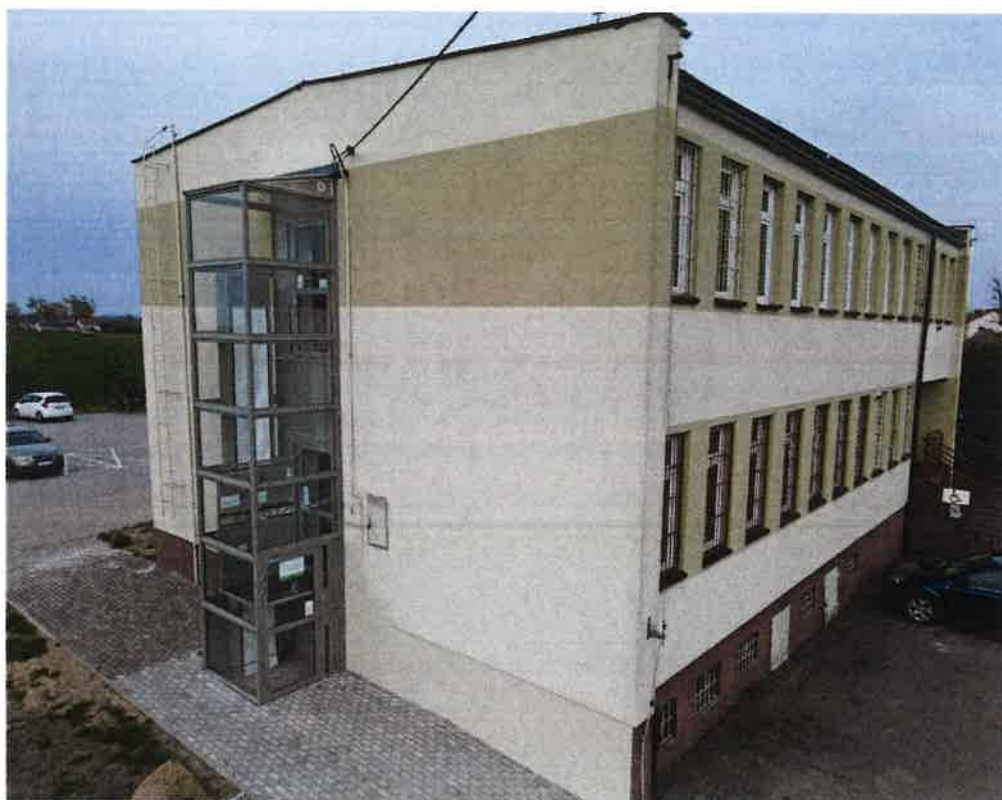
Montaż windy przy Urzędzie Gminy w Dąbrowie
