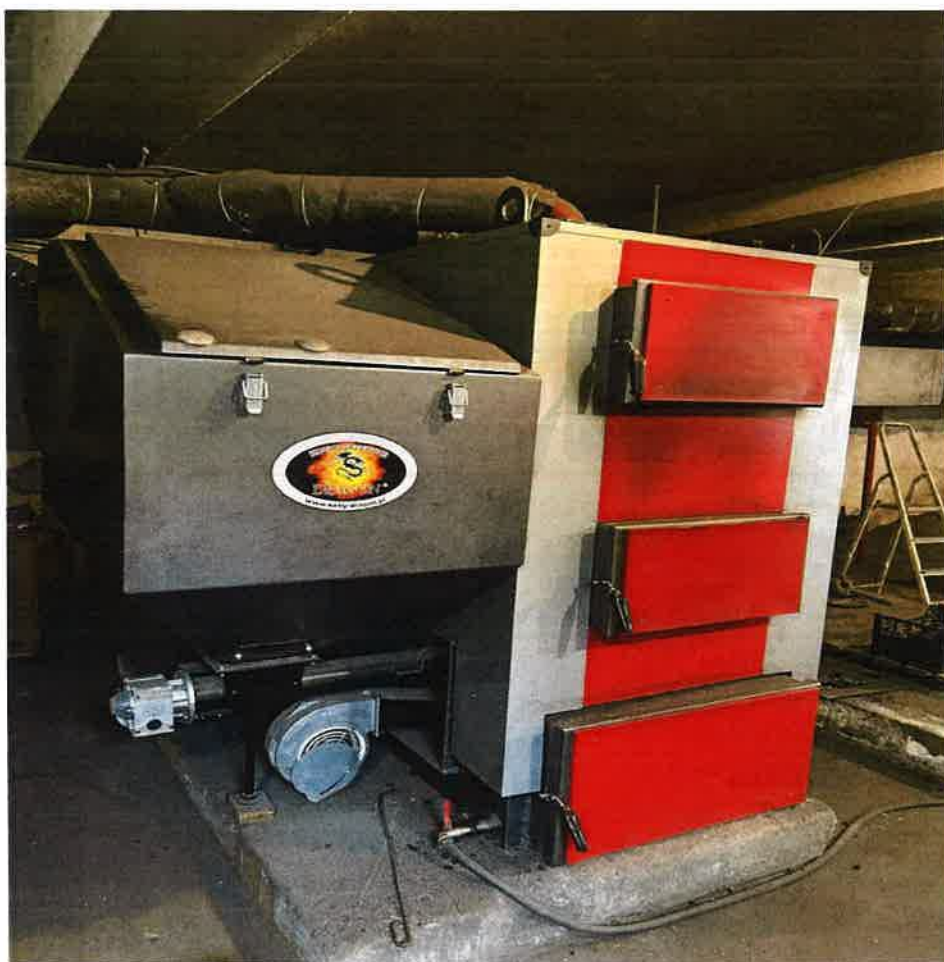
Wymiana pieca centralnego ogrzewania w budynku SP Parlin
