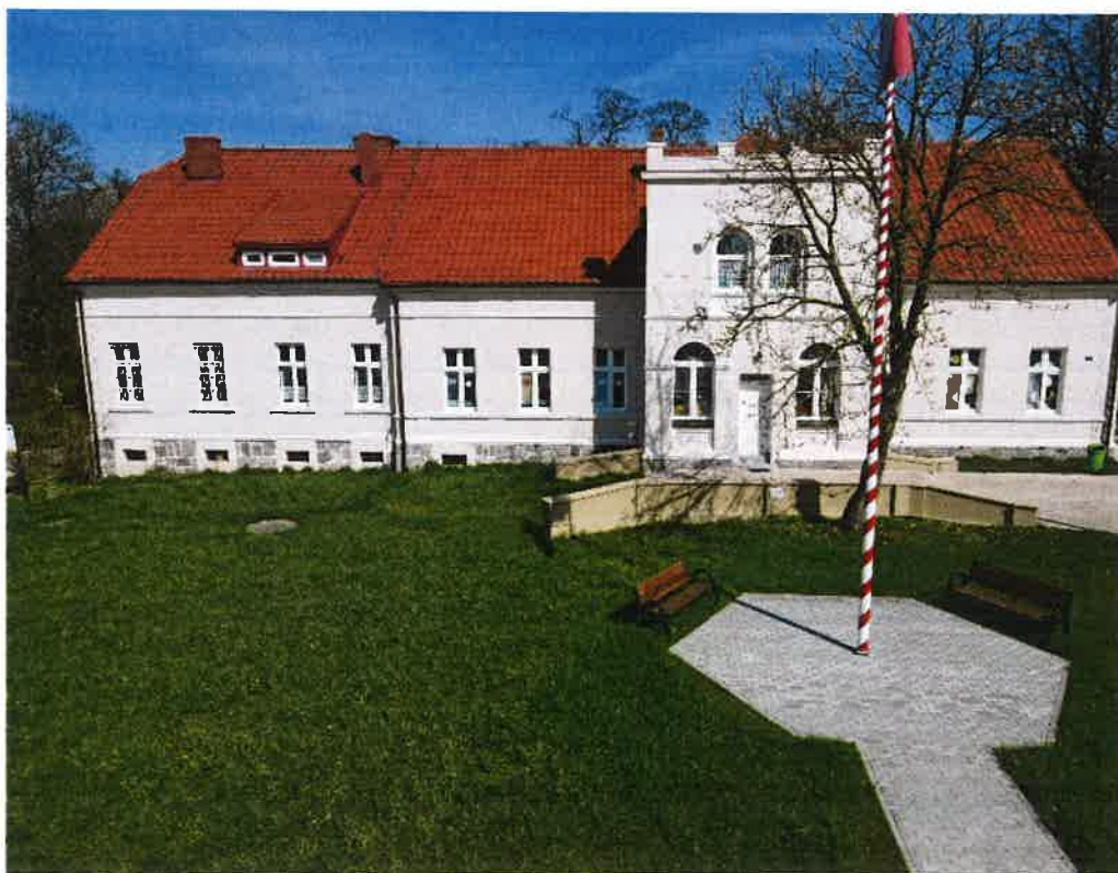
Kompleksowy remont budynku Przedszkola w Dąbrowie
