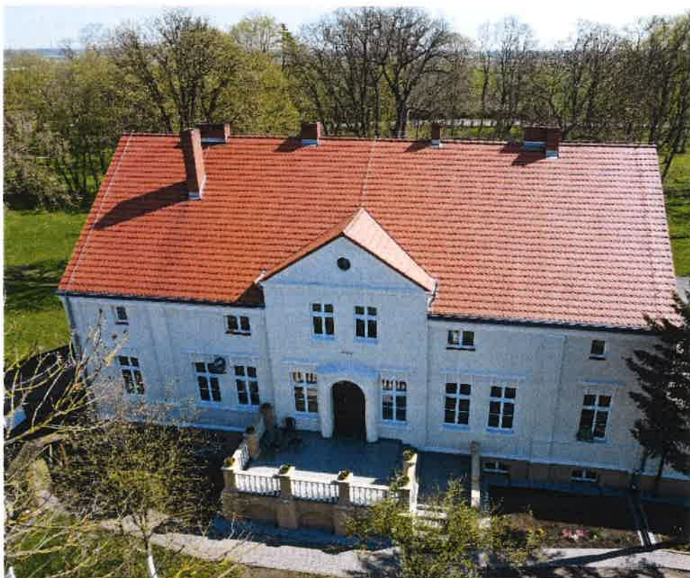
Remont Dworku w Ślaboszewku
