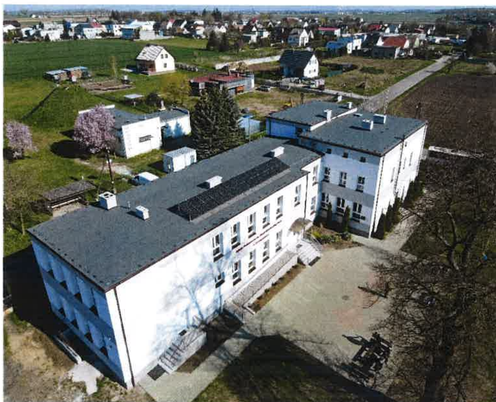
Termomodernizacja Szkoły Podstawowej w Szczepanowie
