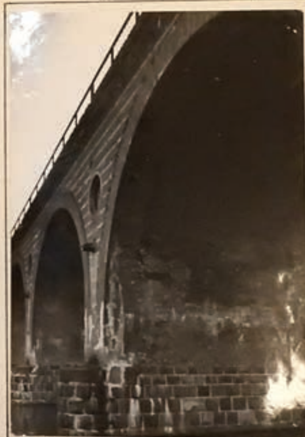
* Most kolejowy na rzece Rodek.
