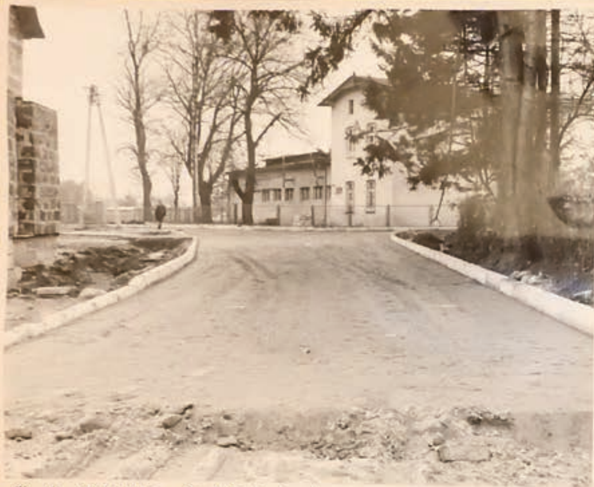
* Ul. Słoneczna w trakcie przebudowy.
