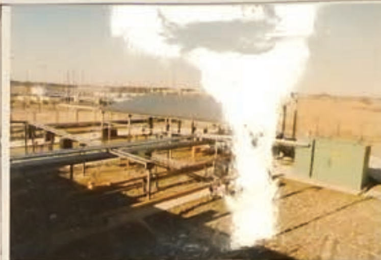
Widok CIĄGÓW GAZOWYCH MIESZALNI - z góry
