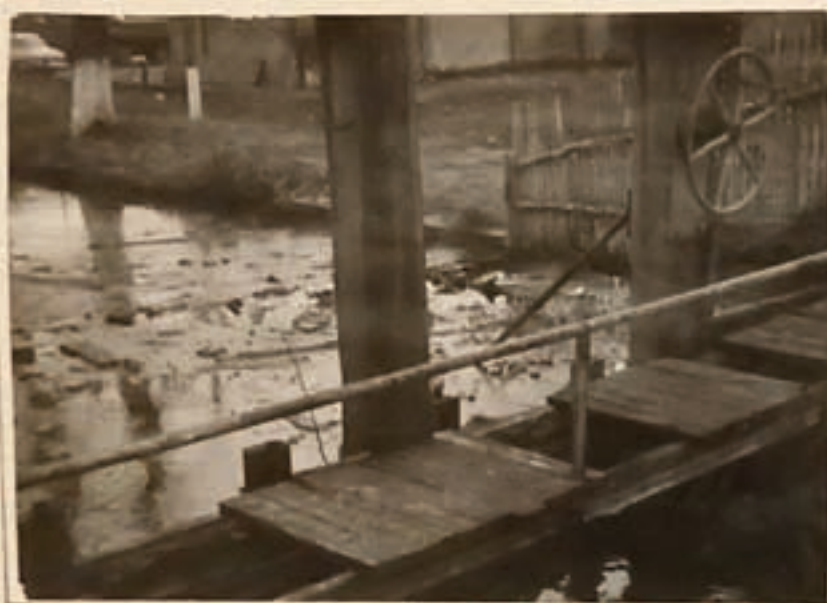
"Zastawka" Urządzenie spiętnające wodę na kanale dotrzymującym wodę do młyna przy ulicy Szczecińskiej.
