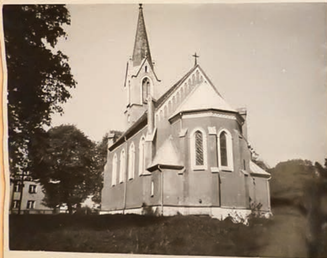
Odmalowany (remont dachu) kościół w Lubiechowie
