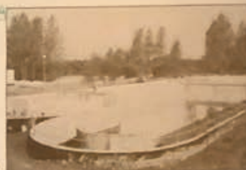
Na budowie Karłińskiej oczyszczalni ścieków w Karlinie. Główny wykonawca „Hydro-Inż. Bud.” z Kołobrzeg, grupę obiektów mały zbiornik w lewym górnym rogu.
