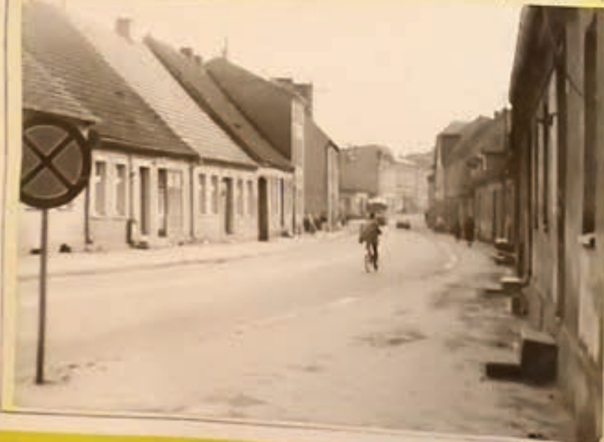
Fragment... ul. Koszalińskiej; główna ulica Karlina, na której znajduje się najwięcej budynków do rozbioru. (9 „numerów”)
