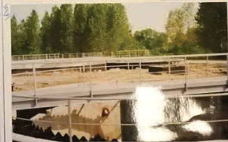
1. Główna Karlinia z pałat pracowników przy budowie - III. 95 2. Ten sam obiekt w VI. gotowy do brzożnego rozruchu.
