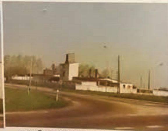
Zakład centrali Kozłowiej w Kozłowie
