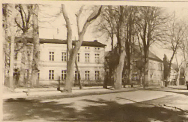
Fot. 1. Budynki Państwowego Ośrodka Maszynowego przy ul. Koszalińska
