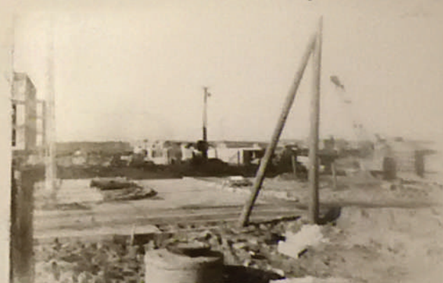
Plac budowy szpitala KPGR.
