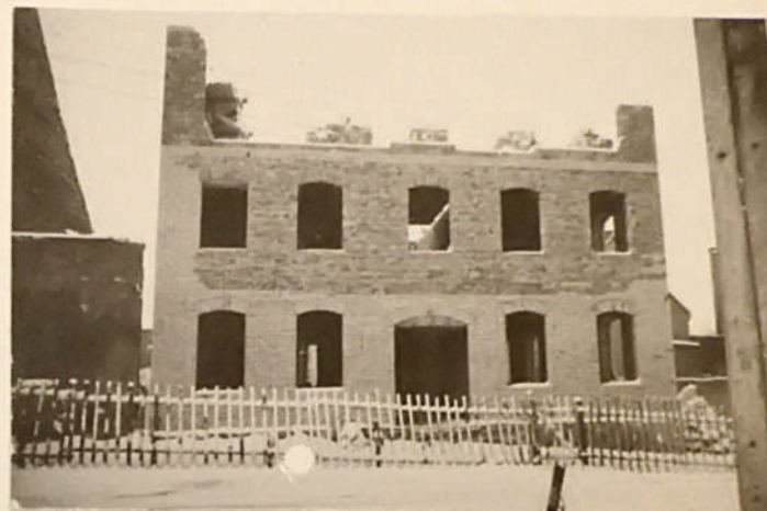
"Dom Napoleona" w trakcie przebudowy ściana frontowa Rok 1971 - 26 luty
