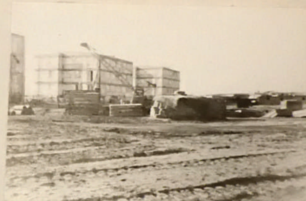
Budynki KPGR w trakcie budowy ul. XXV-lecia PRL
