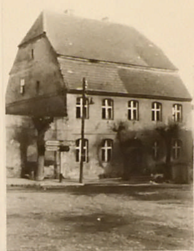
1. "Dom Napoleona" w pełnej krasie przed przebudową.
