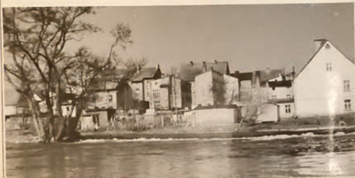
Karlino - widok z mostu od strony Białogardu.
