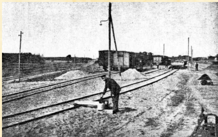
DWORZEC PRZEŁADUNKOWY W KARLINIE
