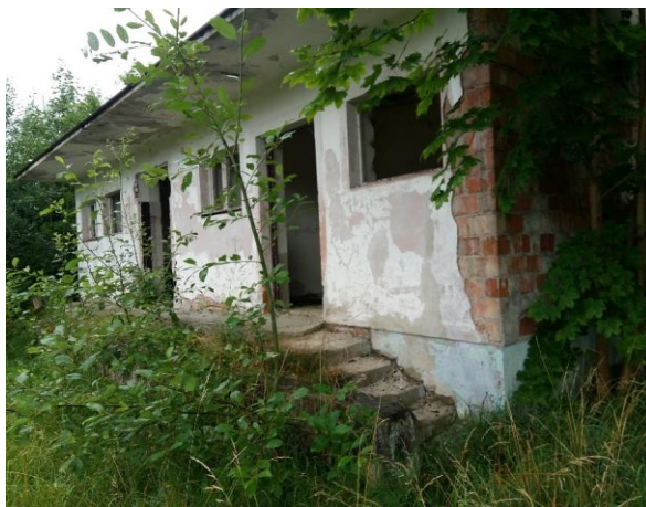
Rysunek 17. Zniszczone zabudowania zlewni mleka - Ubysławice
