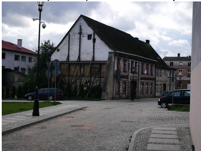
Rysunek 52 . Zniszczone zabytkowe budynki w obszarze rewitalizacji
