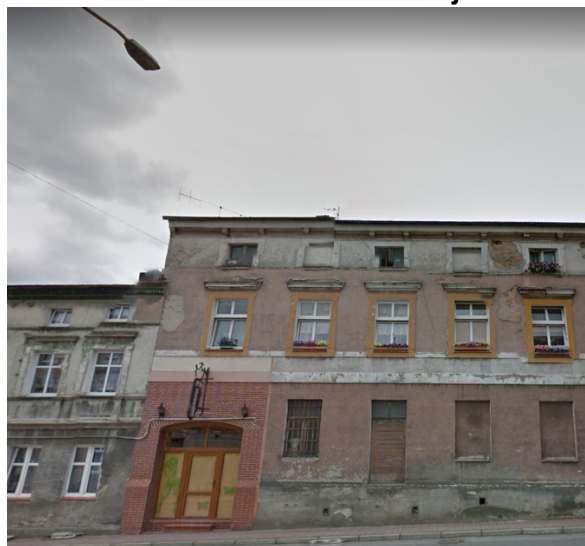
Rysunek 45. Zniszczona kamienica w obszarze rewitalizacji
