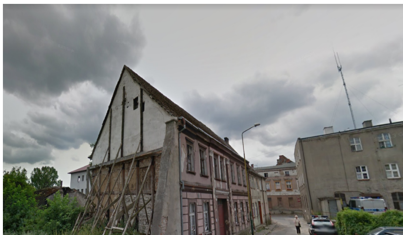
Rysunek 44 . Zniszczone zabytkowe budynki w obszarze rewitalizacji
