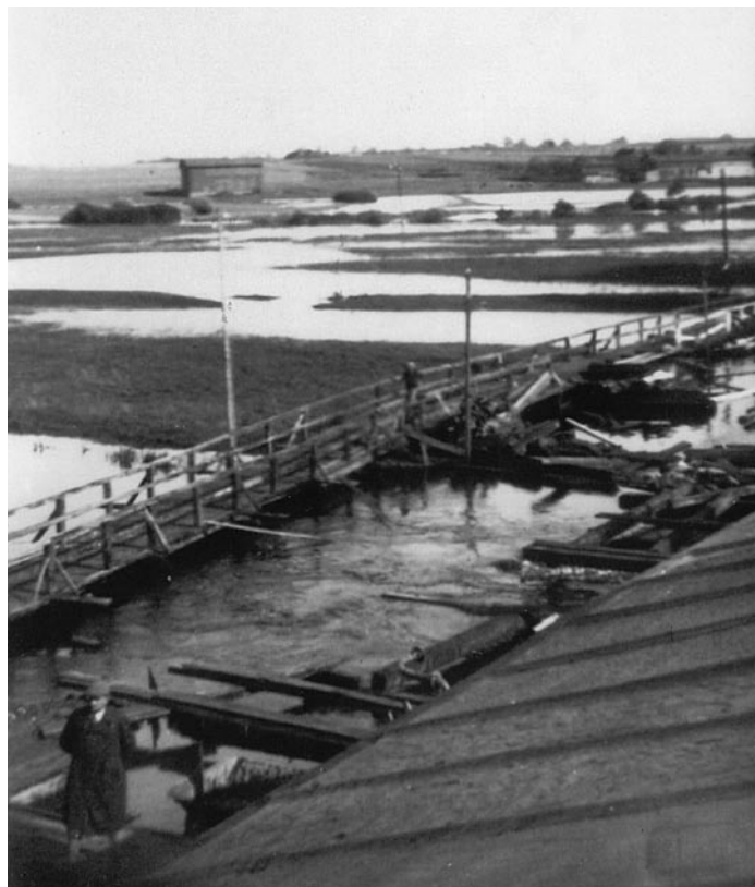
Hochwasser und Überschwemmung bei Bau der Belgarder Brücke; Foto mit Ersatzbrücke
