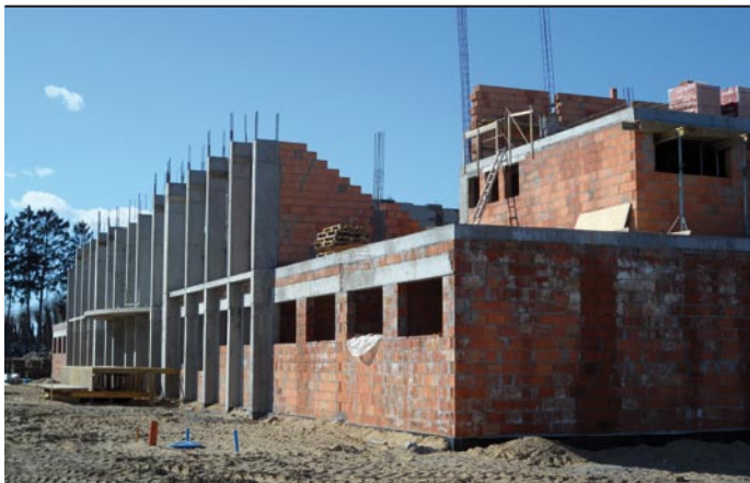
Der Bau der Sporthalle nimmt bereits konkrete Formen an.
