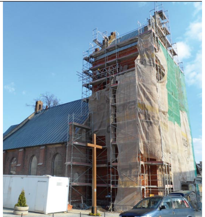
Die St. Michaeliskirche mit Baugerüst
