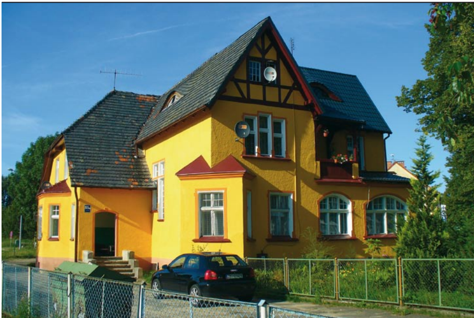
Das ehemalige Wohn- und Bürohaus von Baumeister Ernst Hoffmann im Jahr 2010
