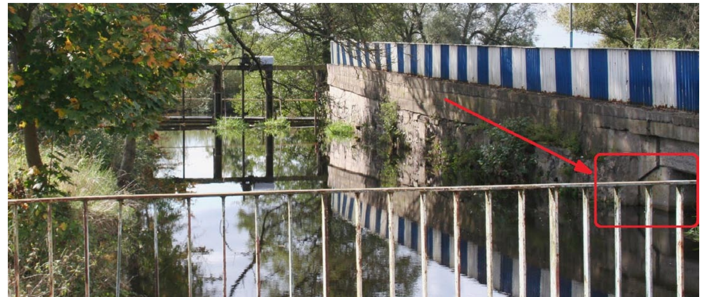
Auf diesem Foto von 2007 noch zu sehen – der Durchlass des Mühlengrabens an der Schlossstraße ...
