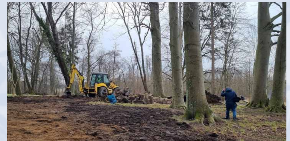
Beginn der Arbeiten 2022
