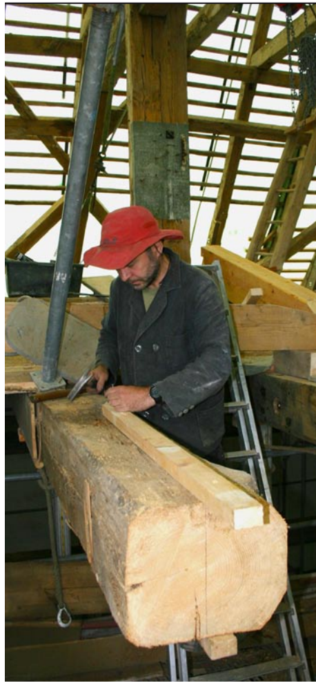
Stück für Stück mussten die schadhaften Teile der Kirchendecke ausgewechselt werden. (Foto: Gerald Gräfe)
