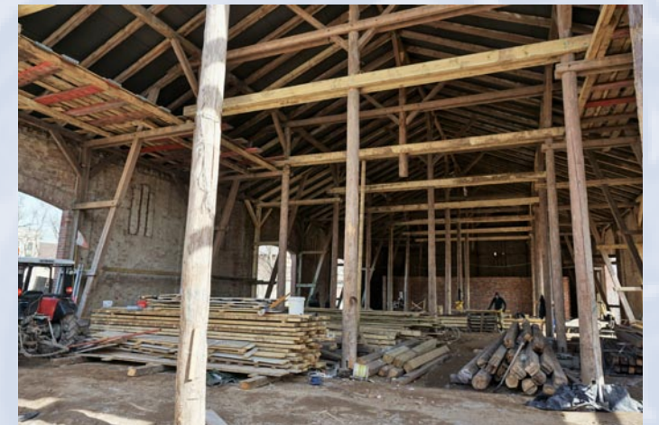
Hier entsteht der große Saal (hinter der alten Mauer im Hintergrund wird sich die Küche befinden)
