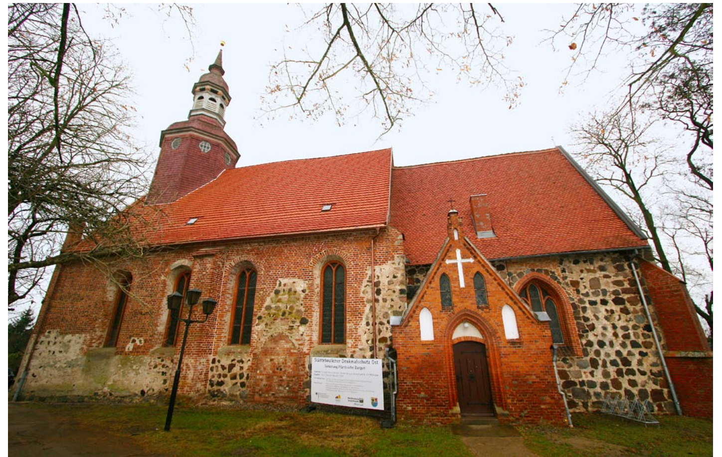
Darguner Pfarrkirche – das Kirchenschiff ist neu eingedeckt, das Gebälk darunter ausgewechselt (Foto: Gerald Gräfe).
