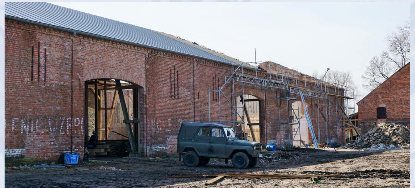
Die alte Scheune zur Hälfte überdacht
