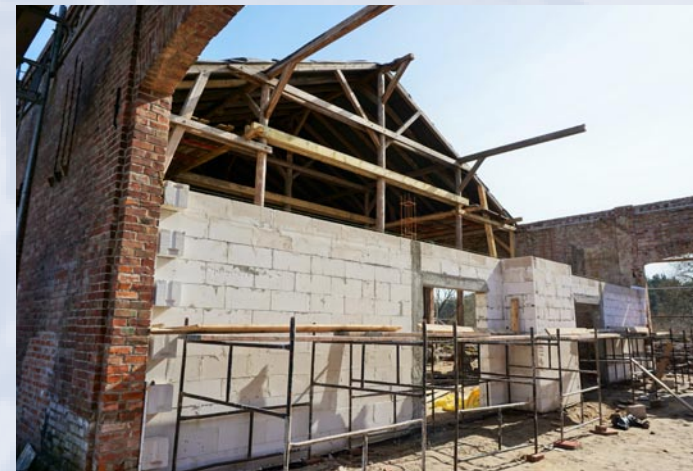
Zukünftige Sanitärräume in der Scheune
