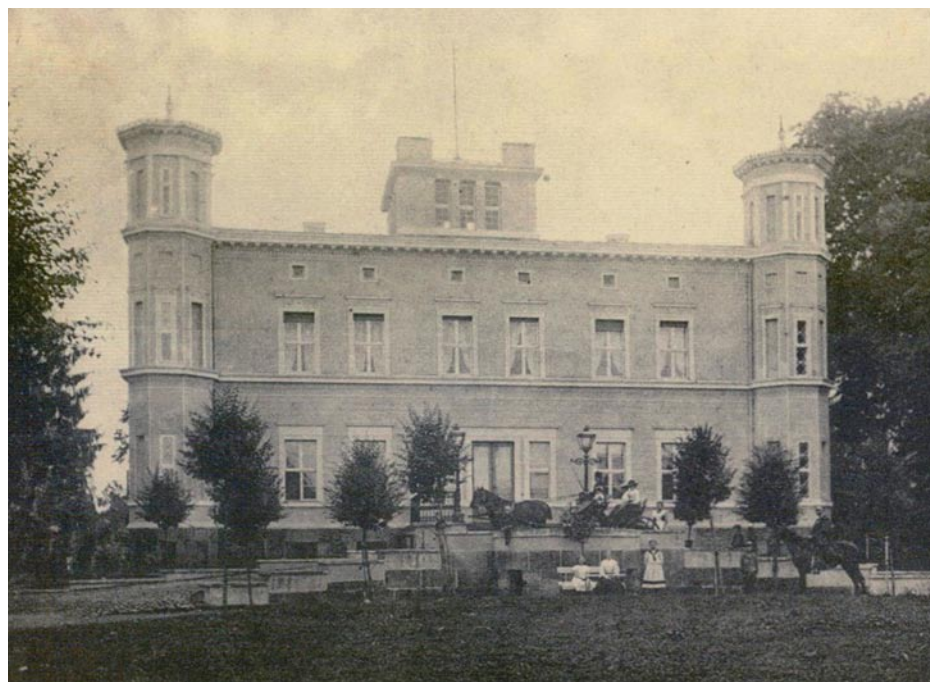
Das Gutshaus nach der Erweiterung 1863, aus: WILKE, S. 64
