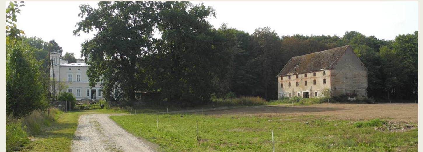
Nur der Speicher ist stehen geblieben.
