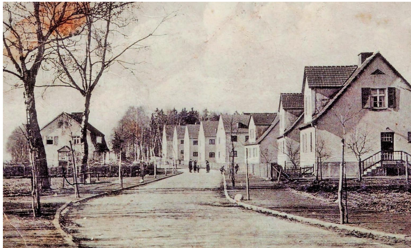
Postkarte aus den späten 1930er Jahren – Blick Richtung Karlsberg (Westen): Die Arbeiten sind abgeschlossen; man sieht die neuen Wohnhäuser, die befestigte Straße (mit dem „Knick“) und die vielen kleinen Birken.
