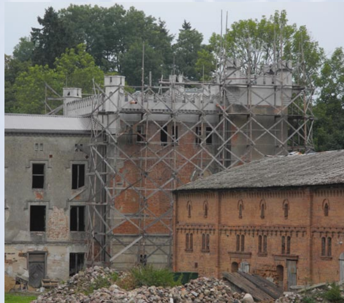
...und die Zinnen am Turm sind fast fertig restauriert.
