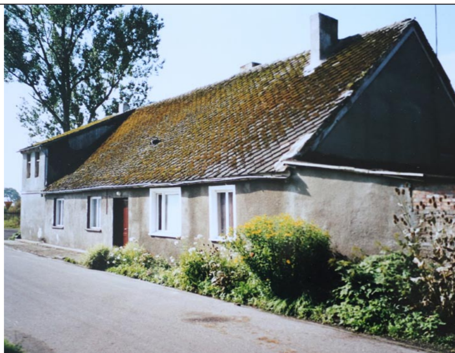
Der ehemalige Gasthof (ca. 2005)
