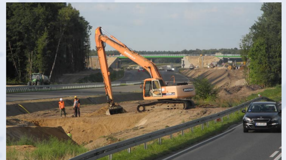
Bau der neuen Schnellstraße bei Plathe/Ploty (2018)
