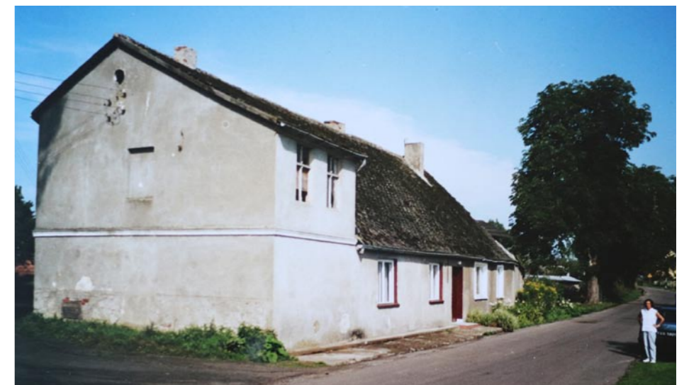
Der ehemalige Gasthof (ca. 2005)
