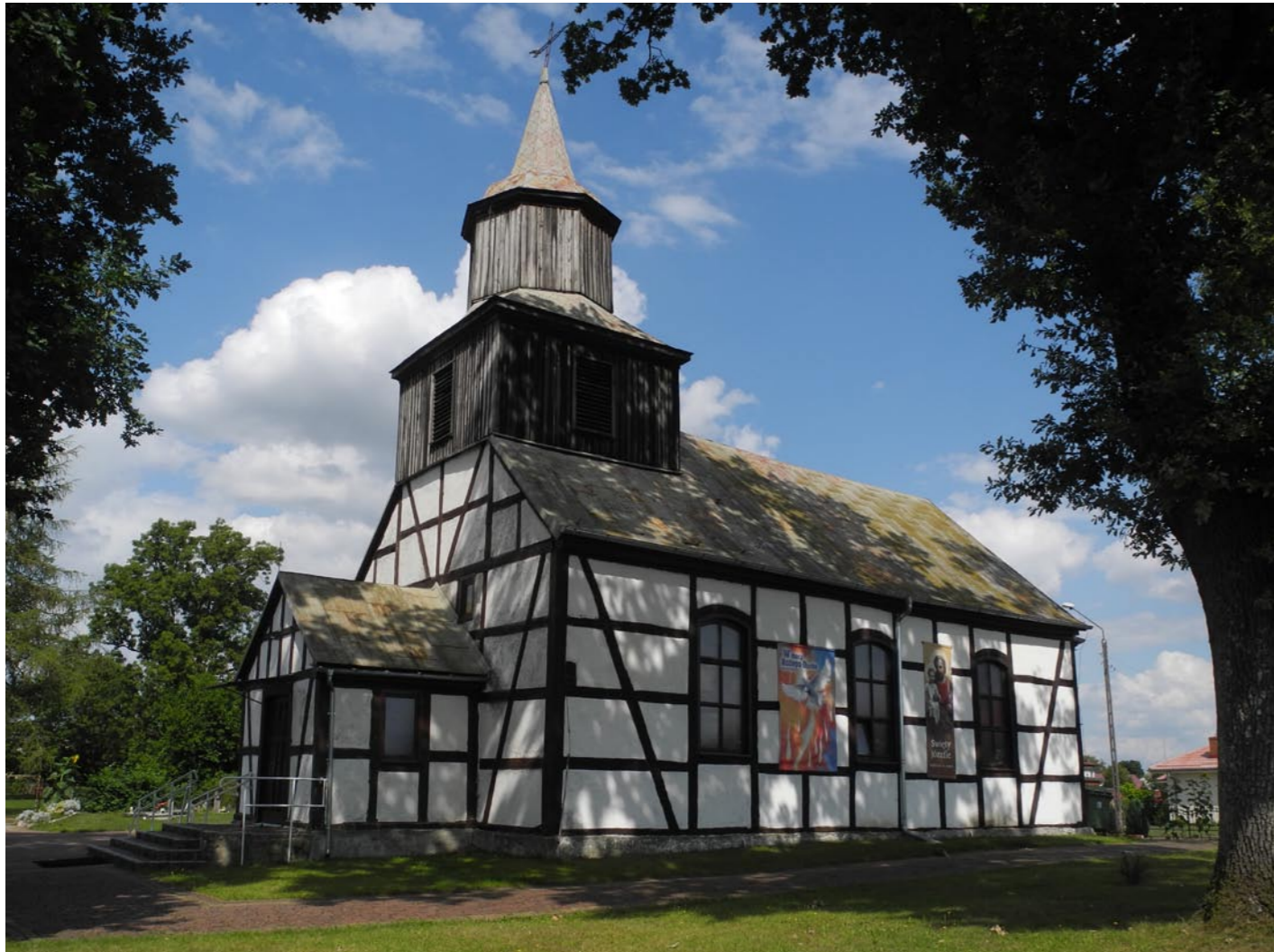
Kirche St. Maria Rosenkranz, erbaut 1842–46, Chor 1946; Blick Richtung Nordosten
