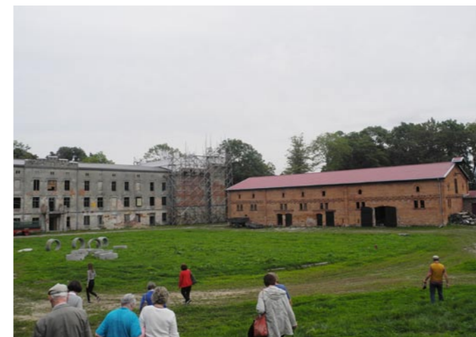
Die Wirtschaftsgebäude haben schon neue Dächer
