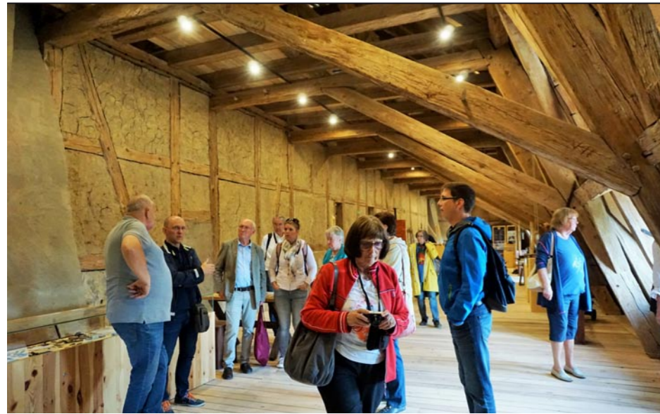
Heinrichsdorf – die mächtige Dachstuhl-Konstruktion des Gutshauses mit dem Wirtschafts-Museum
