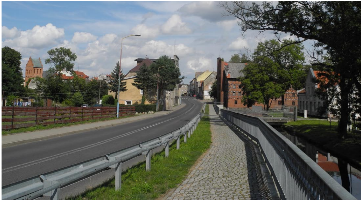
Ortseingang – Schlossbrücke über die Persante
