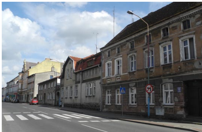
Schlosstr./ul. Szczecinska mit ehem. Sparkassen-Gebäude
