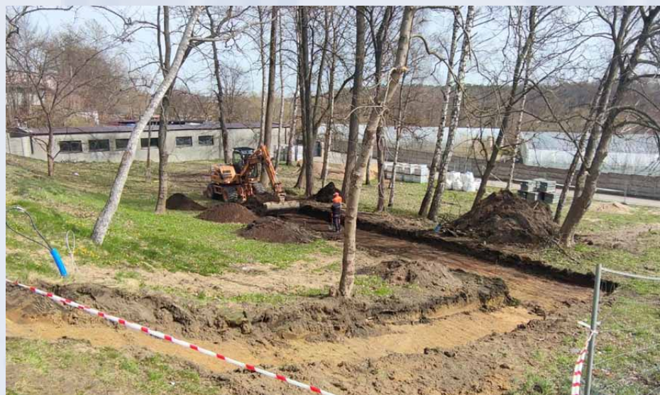
Arbeiten auf dem Gelände an der Radüe
