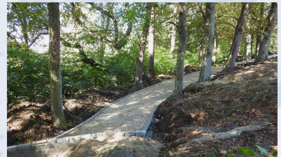
Die Arbeiten auf dem Karlsberg
