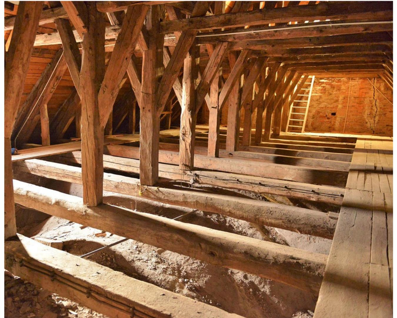
Der Dachstuhl der Körliner Kirche über dem Gewölbe und der sichtbare Riss in der Giebelwand (rechts)
